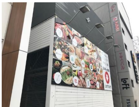
仙台駅換気塔
