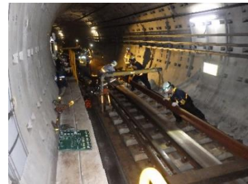
レール交換作業
