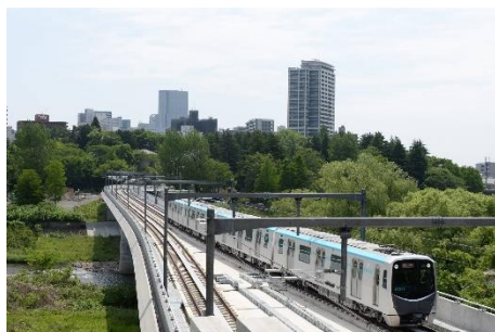
広瀬川橋りょうと車両
